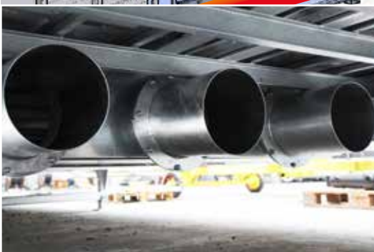
Connecteurs pour l'alimentation en air extérieur avec un diamètre de 300 mm chacun
