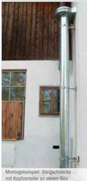
Montagebeispiel: Steigschnecke mit Kopfverteiler an einem Silo
