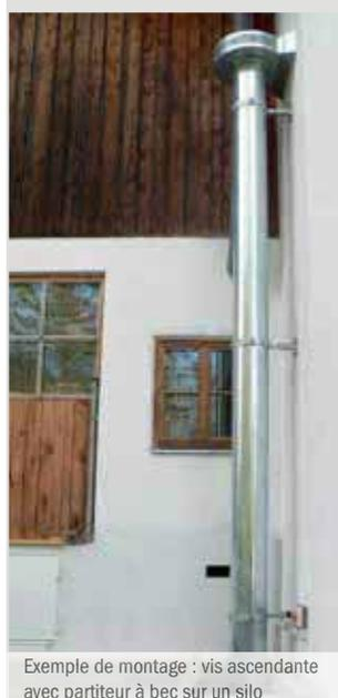
Exemple de montage : vis ascendante avec partiteur à bec sur un silo
