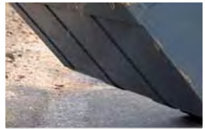
Versteifungsbleche sorgen für einen stabilen Unterbau
