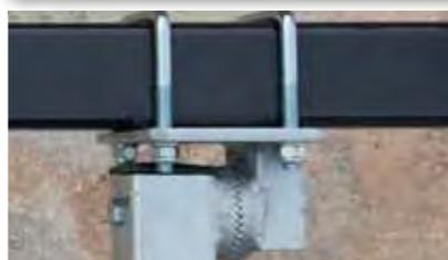
Réglage de l'inclinaison avec le système à disque denté
