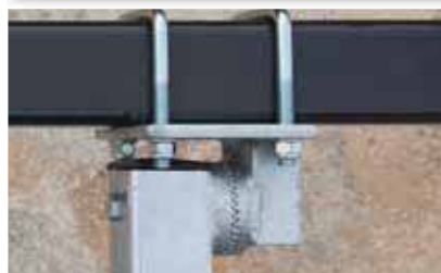
Réglage de l'inclinaison avec le système à disque denté
