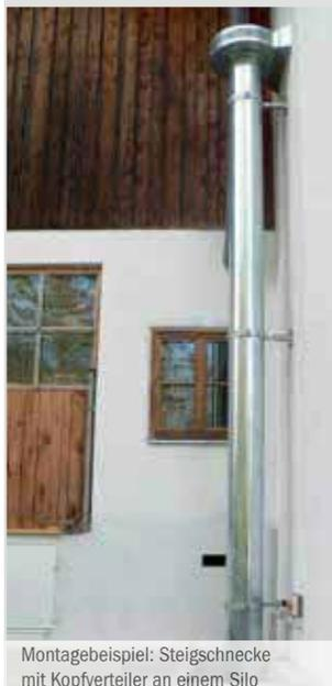
Montagebeispiel: Steigschnecke mit Kopfverteiler an einem Silo
