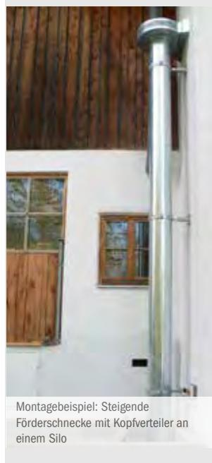
Montagebeispiel: Steigende Förderschnecke mit Kopfverteiler an einem Silo
