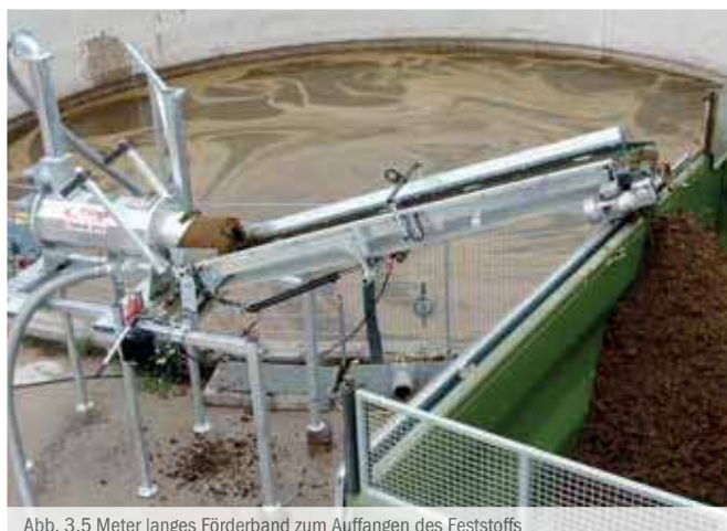
Abb. 3,5 Meter langes Förderband zum Auffangen des Feststoffs
