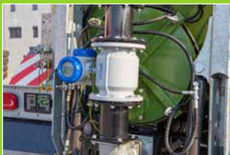
Le débit effectif lors de l'épandage est mesuré par induction à l'aide du débitmètre numérique Optiflux 2300 de la société Krohne.
