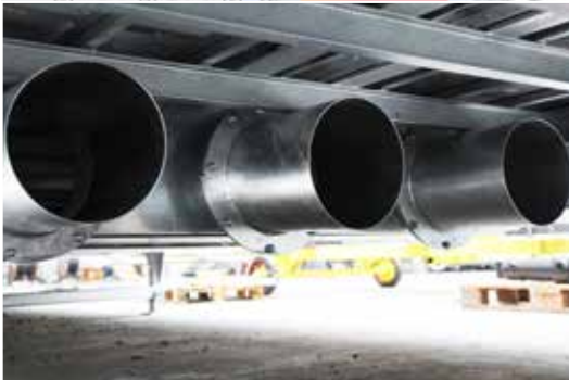
Anschlussstutzen für externe Luftzufuhr mit jeweils Ø 300 mm
