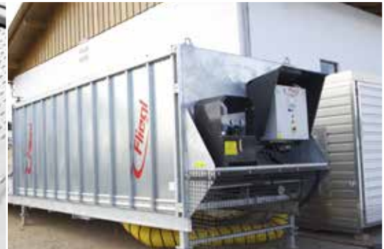
Integrierter Schaltschrank /SPS und Hydraulikaggregat
